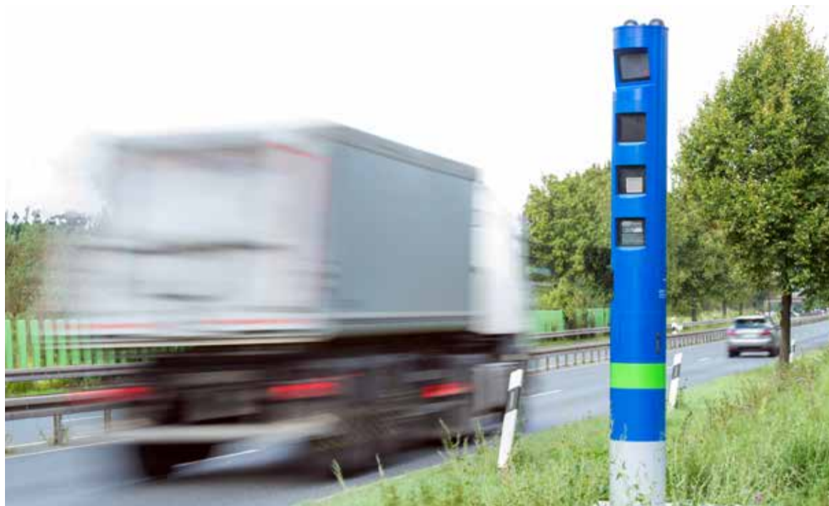
Diese Säule ist kein „Flitzer-Blitzer“ sondern eine neue Mautsäule.
